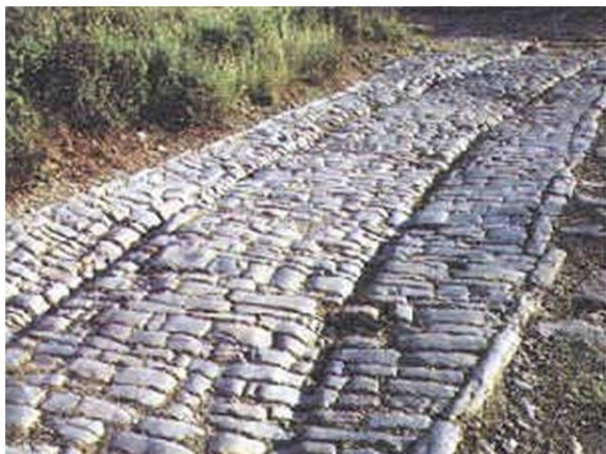
strada consolare romana, lastricata in porfido
