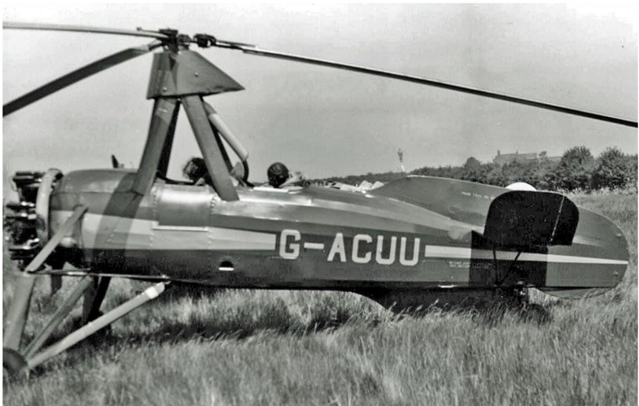
*autogiro La Cierva C.30 – 1933 – notare il particolare della cabina biposto in tandem*
