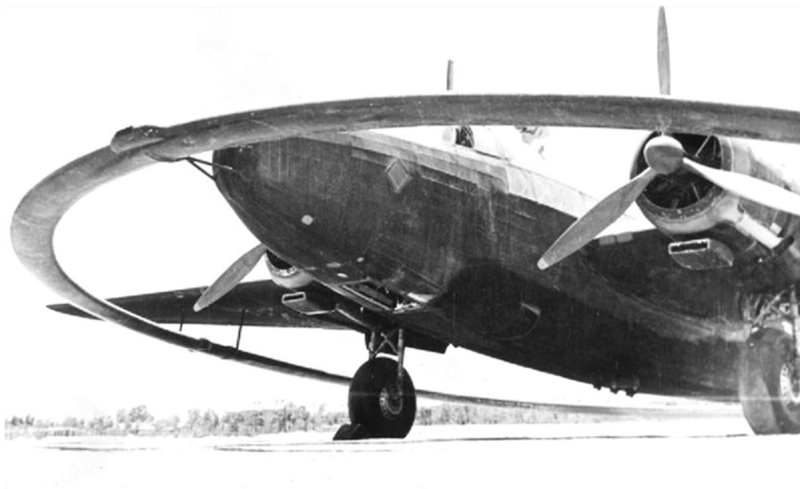
bombardiere inglese bimotore Vickers Wellington dotata di anello metallico con funzione antimina magnetica - 1941
