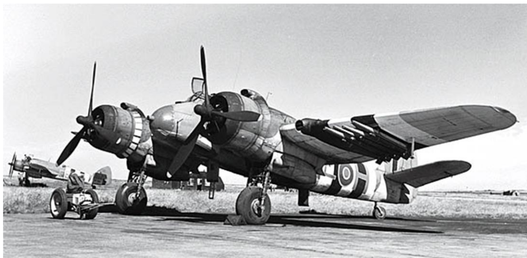
cacciabombardiere inglese Bristol Beaufighter, dotato di radar installato a bordo – 1942
