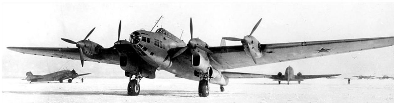
quadrimotore da bombardamento e trasporto sovietico Pe-8 (o Tb-7) progettato dalla squadra di Tupolev / Petlyakov – 1942
