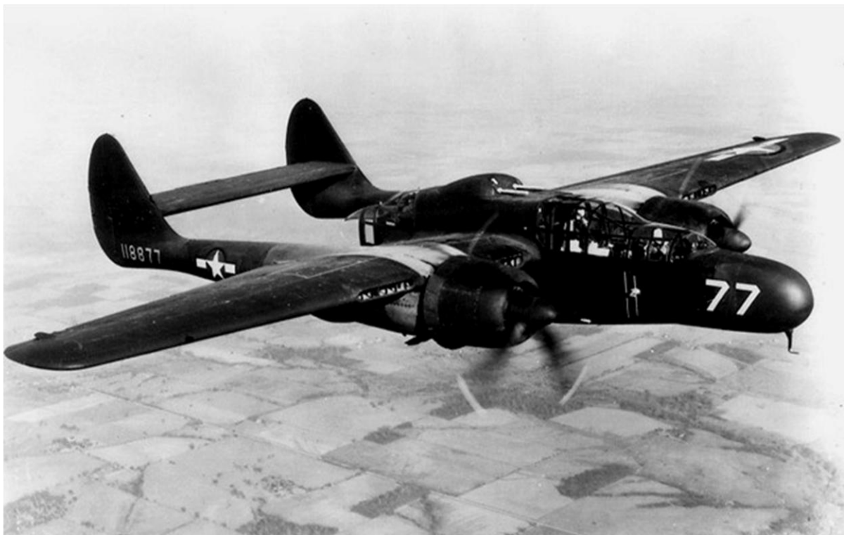
cacciabombardiere pesante notturno americano Northrop P-61 Black Widow – 1945 (notare l'installazione radar a prua)
