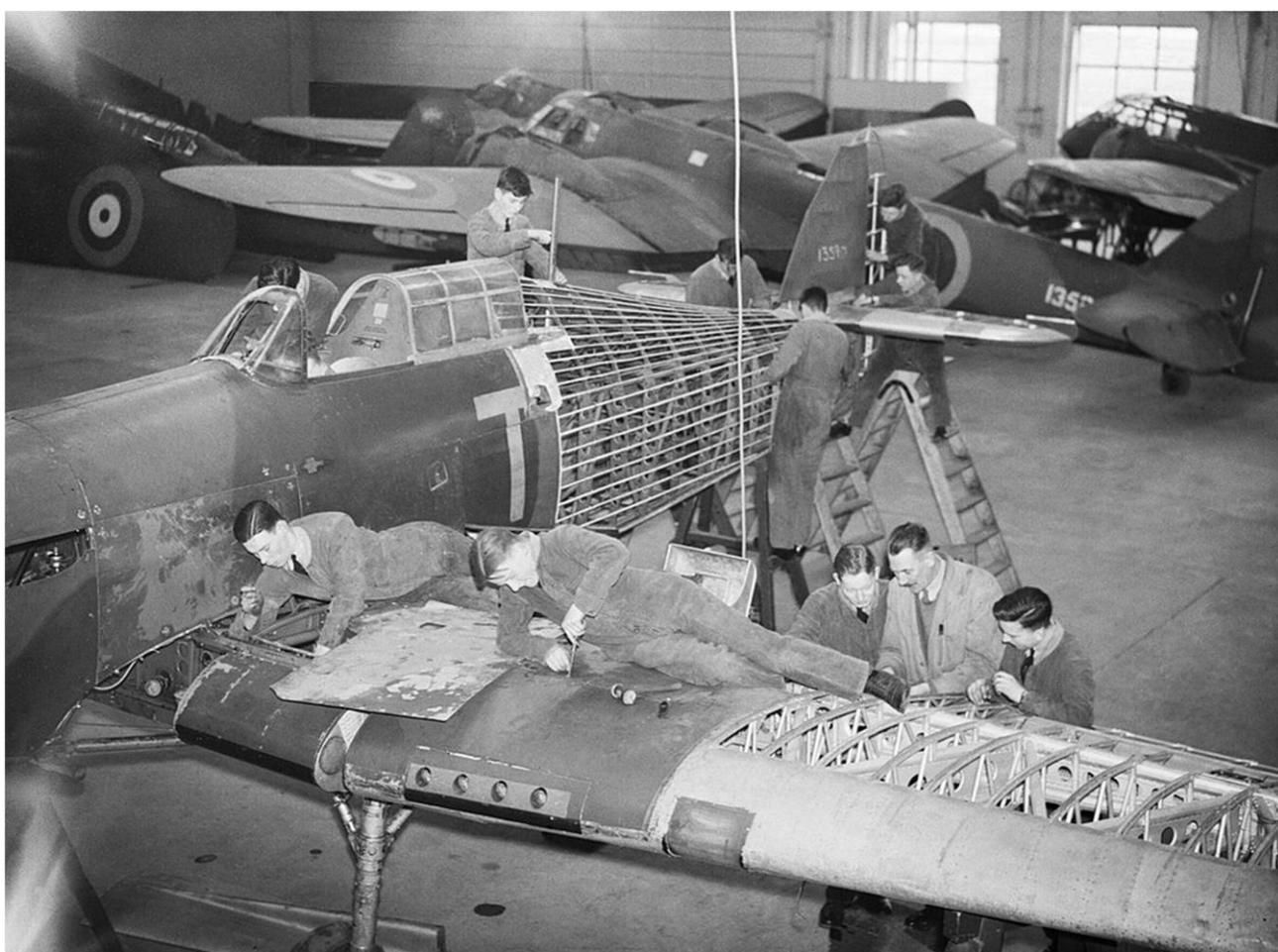
*esempio di fusoliera parzialmente realizzata in tubi d'acciaio saldati – Hawker Hurricane (1936)*
