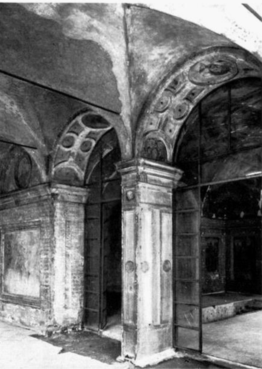
Particolare dell'accesso nord al Santuario.
