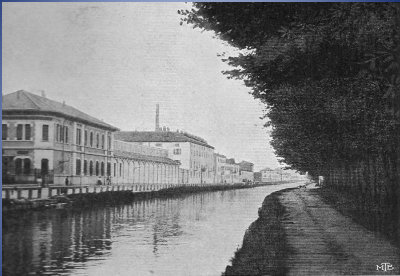
Ceramica Richard-Ginori a S. Cristoforo - stato attuale. — Facciata vista da Levante.
