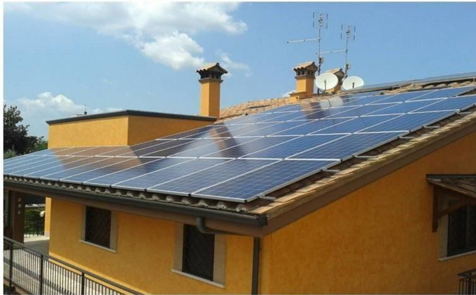
Tetto FV retrofit
