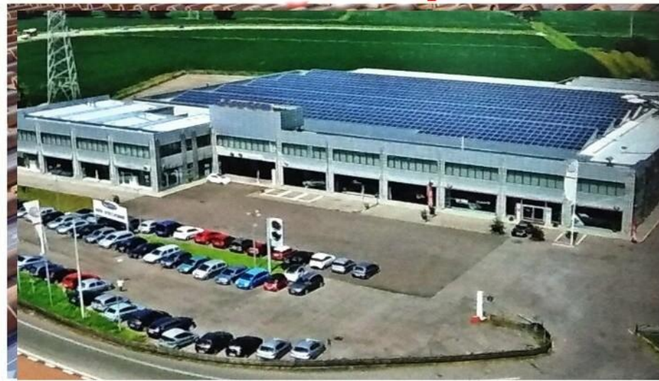
Tetto FV su capannone
